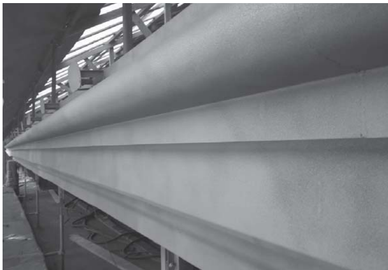
2. ábra: Helyszíni felületelőkészítés
