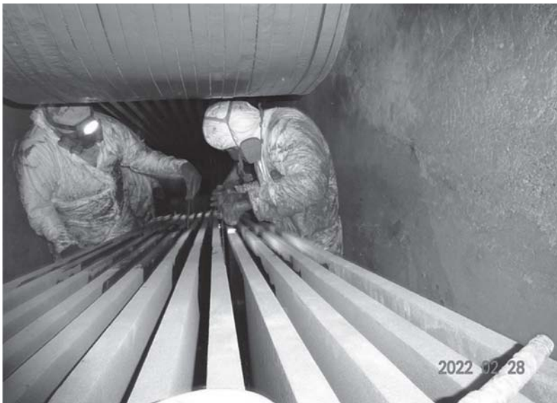
5. ábra: Bemaródott acélszerkezet (balra) és festés a láncok között (jobbra)
