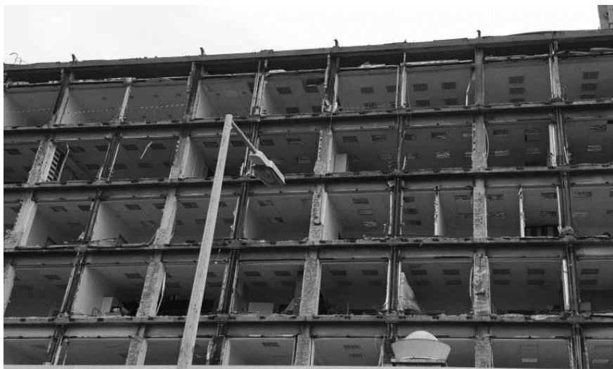
7. ábra: A „B” épület az azbesztmentesítés után és az új homlokzat
